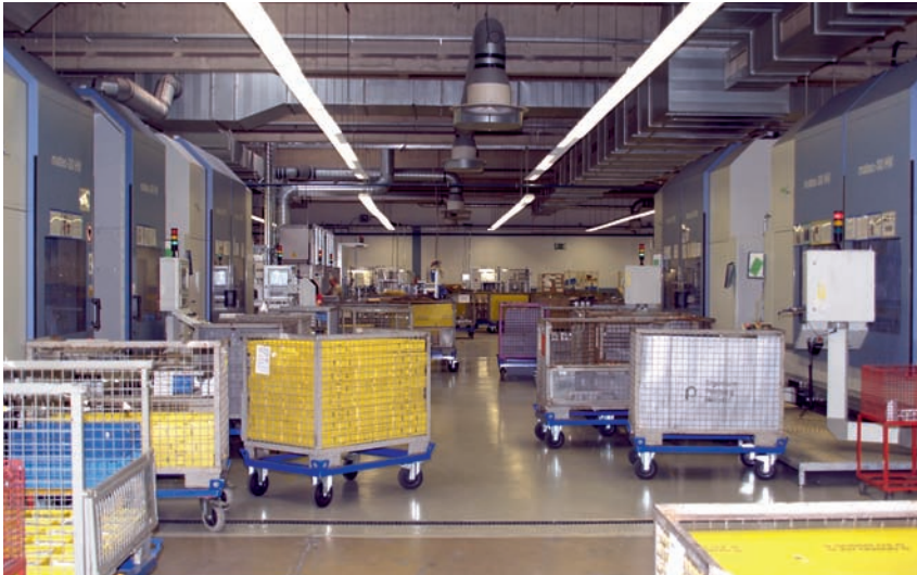
5 Produktives Spalier mit vier von mittlerweile zehn matec-6-Achs-BAZ: in vier Arbeitsschritten werden die Komponenten des neuartigen AGR-Kühlermoduls rührreißgeschweißt und entgratet
